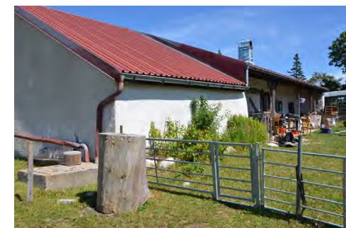
Système de récolte des eaux de pluies dans une citerne dans le Parc Jura vaudois. E. Reynard
