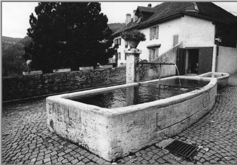
Bassin de fontaine en calcaire urgonien (Crétacé inférieur) provenant de la forêt du Chanay de Croy. Village de Croy (Vaud).
