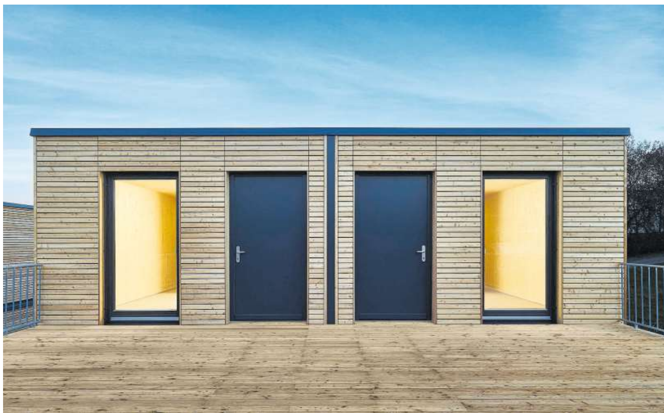
In Winnenden startete das Pilotprojekt Aktivhaus Serie 700, das aus 38 vorgefertigten Modulen besteht.
