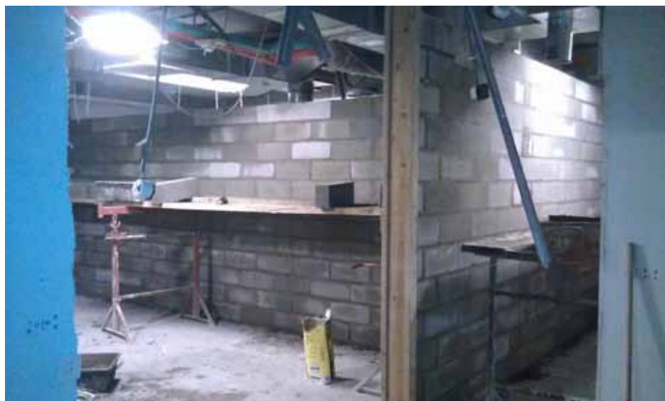
Chantier de maçonnerie pour les futurs ateliers du musée en mars.
