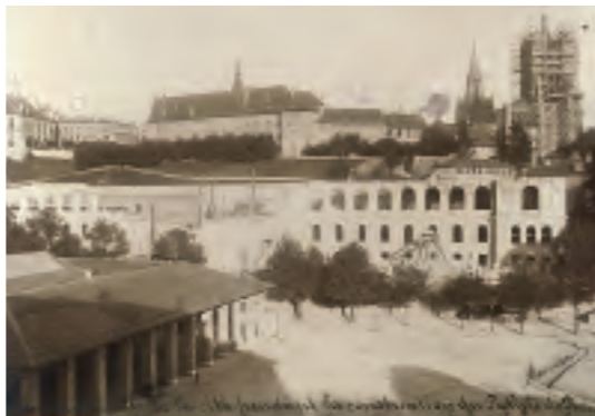
Vers 1900, les parties en pierre de Villebois sont terminées.
