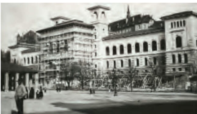
Vers 1903, le corps central est en voie d'achèvement. On distingue les échafaudages de la future pergola sud.
