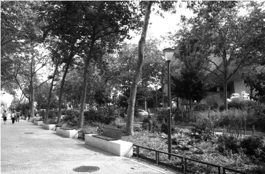
Figure 1 : Rue Garibaldi à Lyon, juin 2016. Les eaux pluviales sont collectées par des noues végétalisées et stockées dans un bassin enterré, pour réutilisation pour l'arrosage des végétaux et le nettoyage des voiries (source : auteure, 2018).
