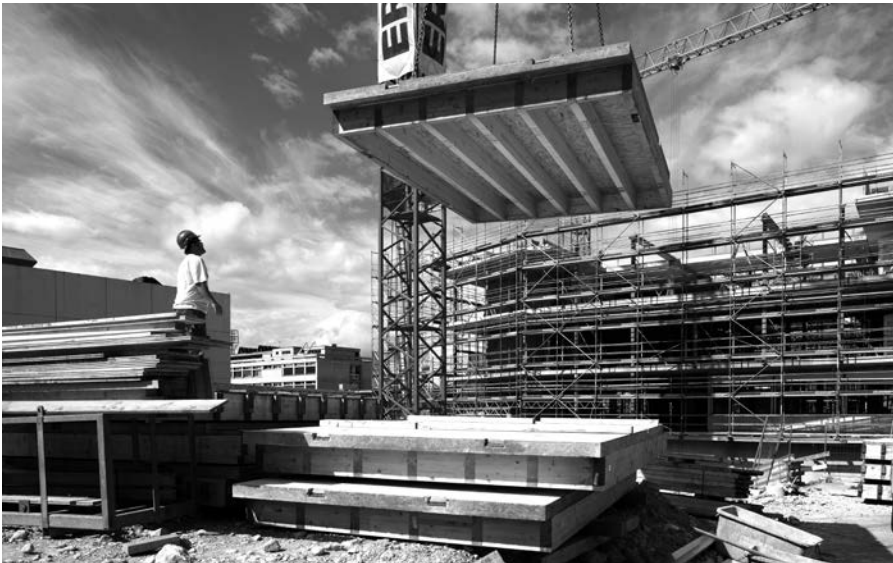
Figure 4 : Montage sur le chantier des éléments de dalles préfabriqués en bois-béton. (photo : Yves André)
