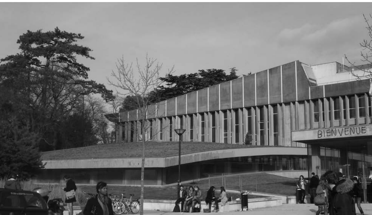
Figure 1 : Toiture végétalisée de l'Université de Nantes (source : xxx )
