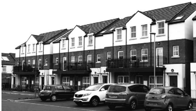
Figure 3 : Logements dits partagés au sud-est de Belfast, où l'on ne trouve aucun signe communautaire - Herrault, 2016
