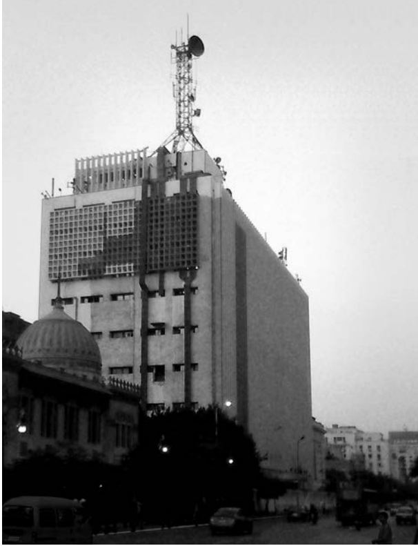
Figure 2 : « Ramses Exchange », siège de Telecom Egypt au centre ville du Caire et point de passage central des câbles sous-marins transcontinentaux passant par l'Égypte. (source : A. Elka-shash)
