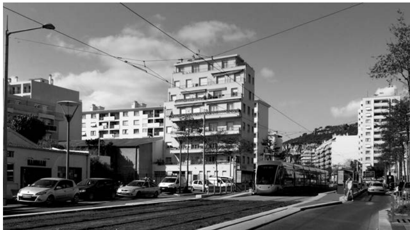
Figure 1 : Exemple d'aménagement de tramway en « site propre ». (source : auteure, Nice 2015)
