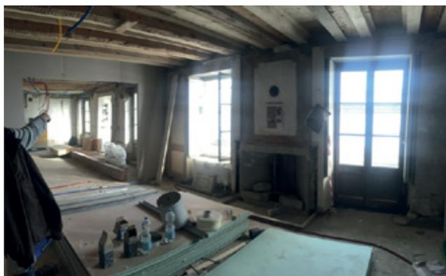
**Fig. 12:** La Maison en chantier. Ouverture des cloisons en rez-de-chaussée - Source OUVDD, 2017
