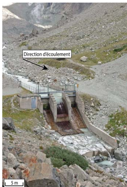
Figure 1a. Exemple d'une prise d'eau (ici Bertol Inférieur, Arolla, VS). Figure 1b.) Schéma classique d'une prise d'eau avec deux bassins de gestion des sédiments (modifié d'après Lane et al., 2016).
