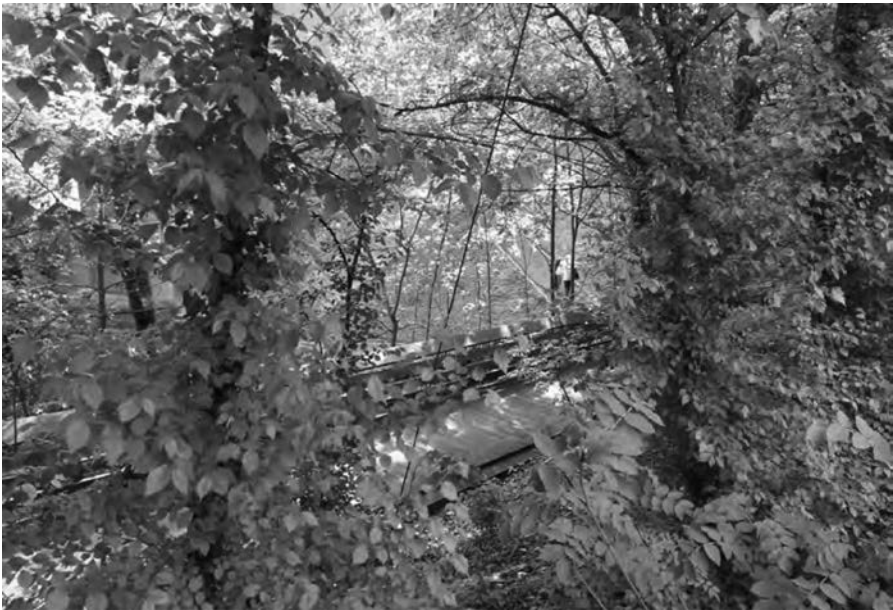
Figure 2 : Passerelle dans le couloir végétale de la rivière Paudèze, Lausanne. (source : photo Florinel Radu)
