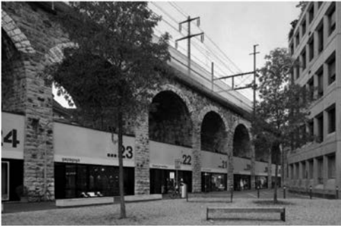
IM Viadukt, EM2N architects, Zürich, Switzerland, 2010 – viaduc ferroviaire, arches maçonnées (Photo: Roger Frei)
