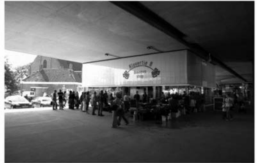
A8ERNA, NL Architects, Koog aan de Zaan, Zaanstad, Netherlands, 2003 – viaduc routier, piles et tablier béton (Source : NLarchitects, http://www.nlarchitects.nl/ )
