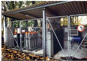
Séparation effectuée avec un mur
