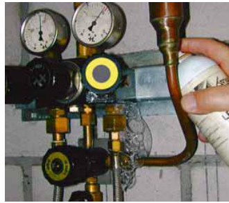
Contrôle de l'étanchéité de l'installation
